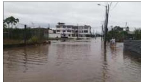
Fotografía 3 Inundaciones cantonales por lluvias excesivas
